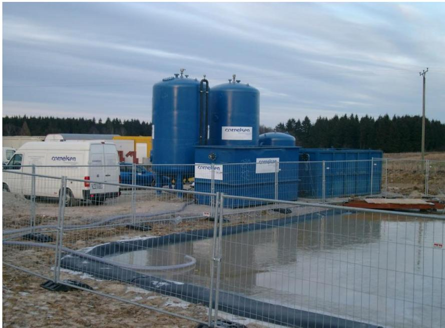
**Bild 1 Temporäre Grundwasserreinigungsanlage in Brilon-Scharfenberg (Jan. 07)**
