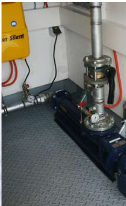
Austragpumpe des Flüssigkeitsabscheiders
