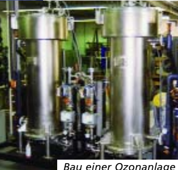
Bau einer Ozonanlage
