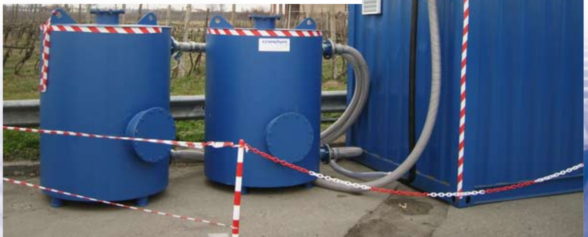
Anlagencontainer mit den beiden Luftaktivkohlefiltern (installiert auf einer Raststätte)
