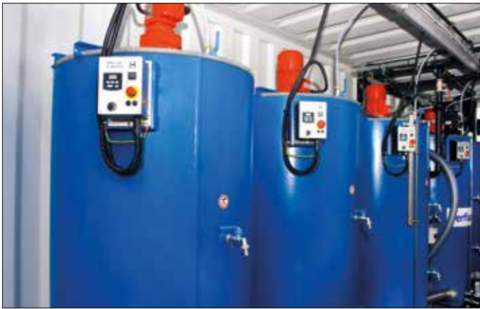
02 PerfluorAd-Rührreaktoranlage für Pilotanwendungen im Grundwassersanierungsbereich
