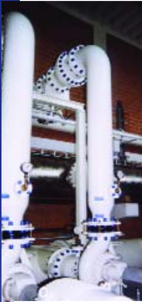
Druckerhöhungspumpen
