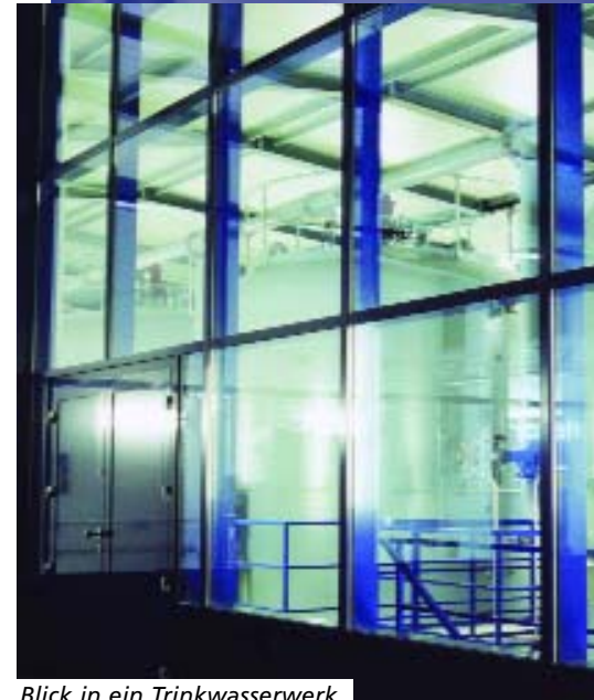
Blick in ein Trinkwasserwerk
